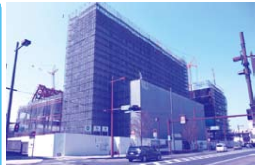
来年5月オープンに向け、工事中の大工町再開発
